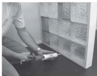
Pose du silicone entre cadre et gros oeuvre
